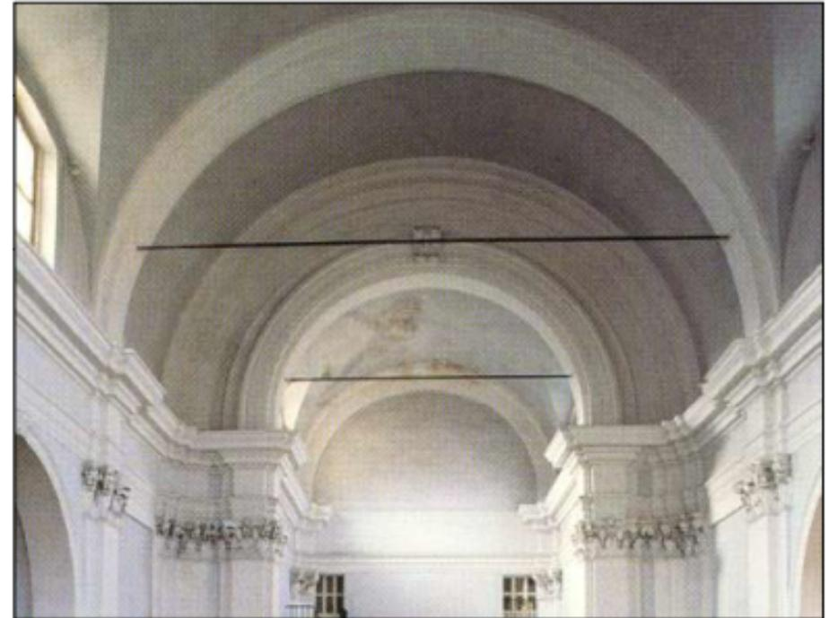
Dimensionamento della sezione: si affida alla catena l'intera spinta orizzontale ( $F_c = F_o$ ).
